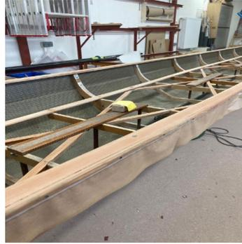
Sobald ich mit dem Schleifen fertig bin, werde ich alles mit Klarlack lackieren. Danach darf ich nochmal alles schleifen (natürlich nicht so intensiv wie beim Ersten mal), um dann eine weitere Schicht Lack drauf zu packen. Insgesamt sind 5 Lackschichten geplant. Wenn das geschafft wurde, schauen der Bootswart und ich die Rollsitze, Rollschienen, Stemmbretter etc. an und entscheiden was damit gemacht werden sollte. Bis dies passiert, wird es aber noch dauern.
